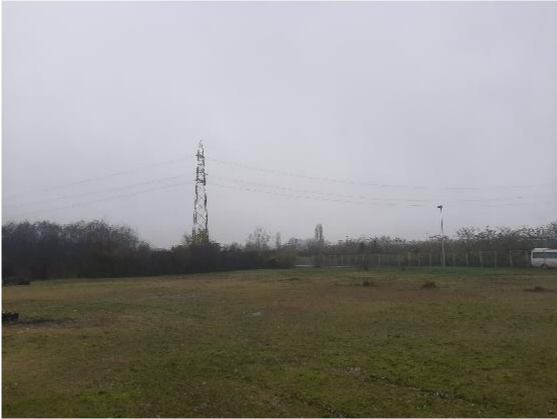
Fotografija br.2, Pogled ka zapadu (početak kolosijeka-skretnica)
