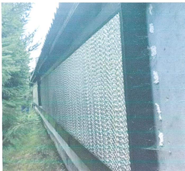
Slika. Saće za klimatizaciju hale
